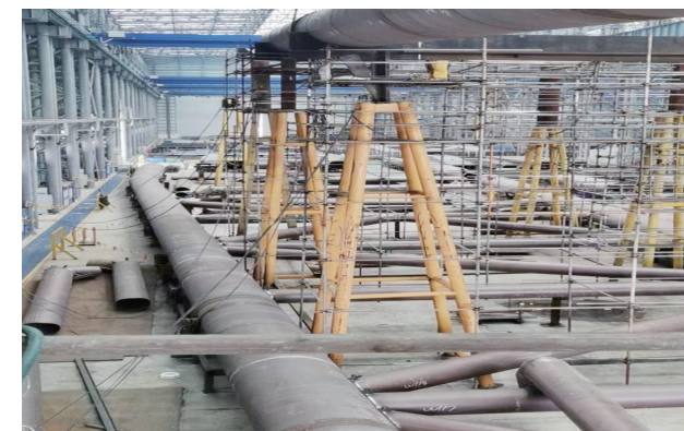
JSD6000铺管船托管架项目 Jsd6000 pipe laying vessel stinger project
